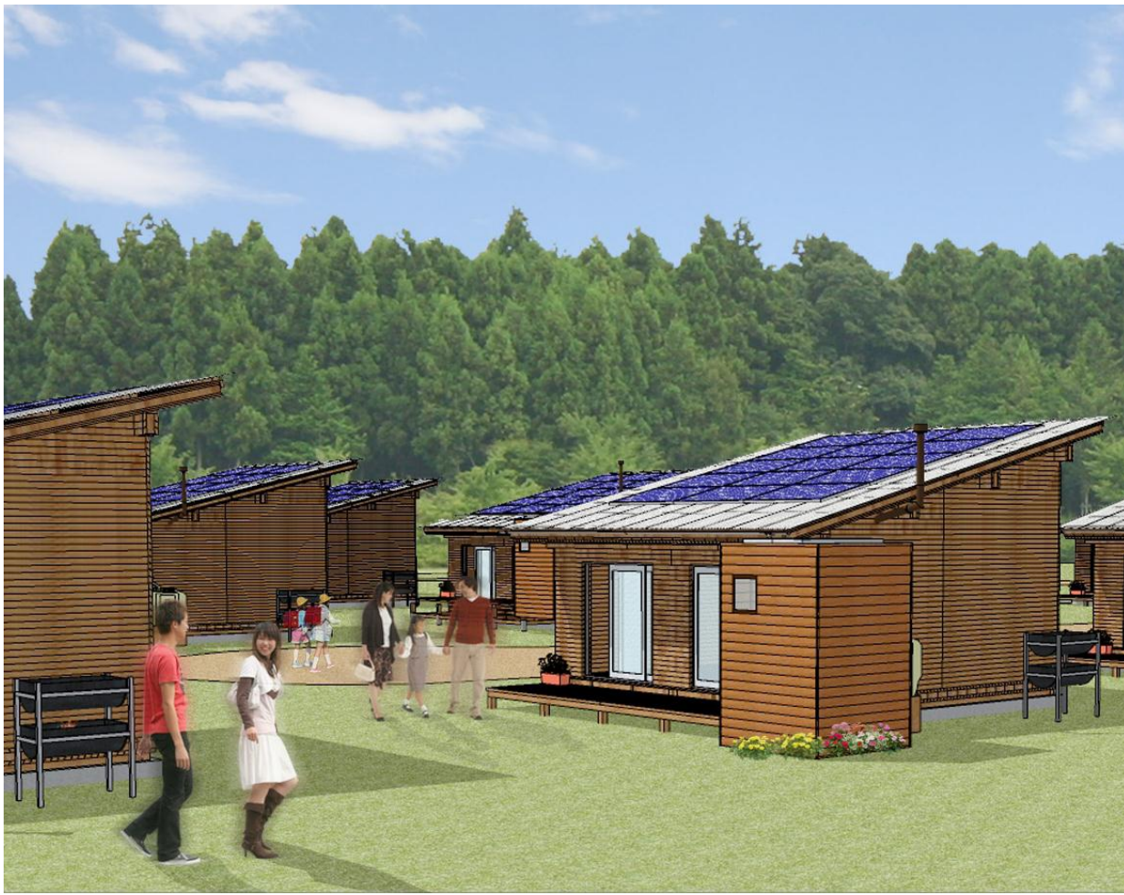
屋根にソーラーパネル設置した応急住宅
